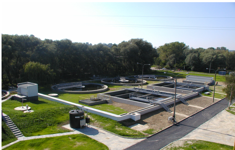
Oczyszczalnia po przeprowadzonej rozbudowie i modernizacji
